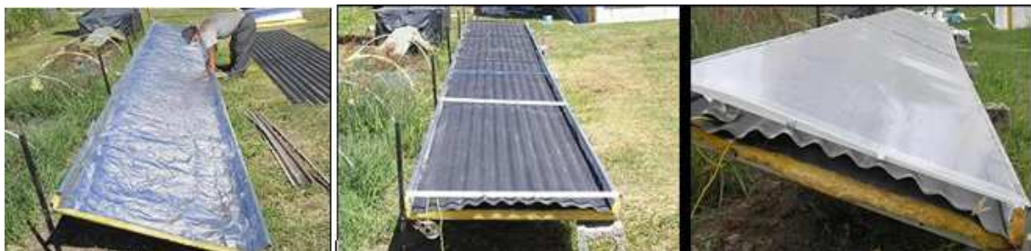
Figuras 2, 3, 4: Etapas de la construcción del prototipo de colector.
