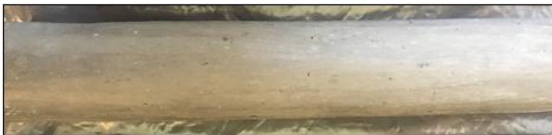
Figura 25. Detalle de la presencia de concreciones de Fe y Mn de la muestra 3. Fuente propia
