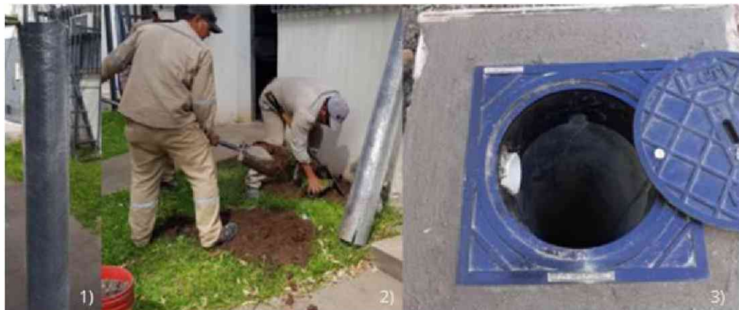
Figura 2. Perforación y colocación de sensores. 1) Conducto para protección de sensores. 2) Realización de la perforación. 3) Perforación con sensores
