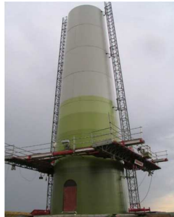
Figura 7 - Torre de hormigón postesado de 97m – Enercon E82
