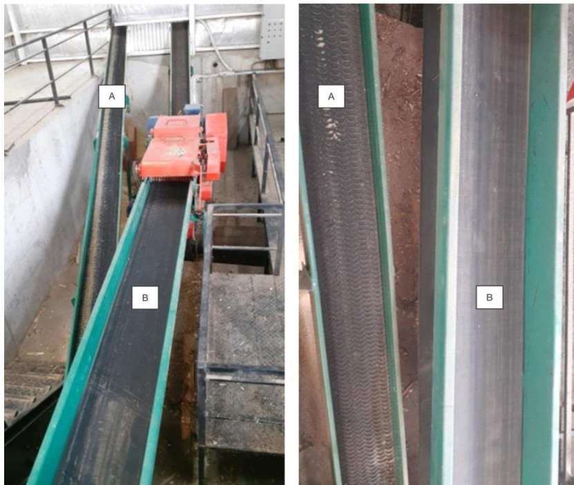
Figura 3.26. Cintas de alimentación: (A) estriada en pendiente; (B) lisa horizontal-CTM. Fuente: propia (2021).
