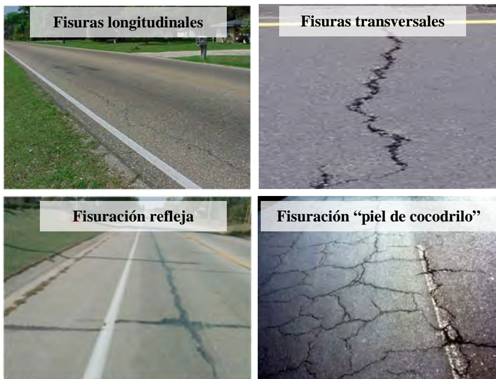
Figura 2.1. Tipos de fisuración en pavimentos asfálticos.
