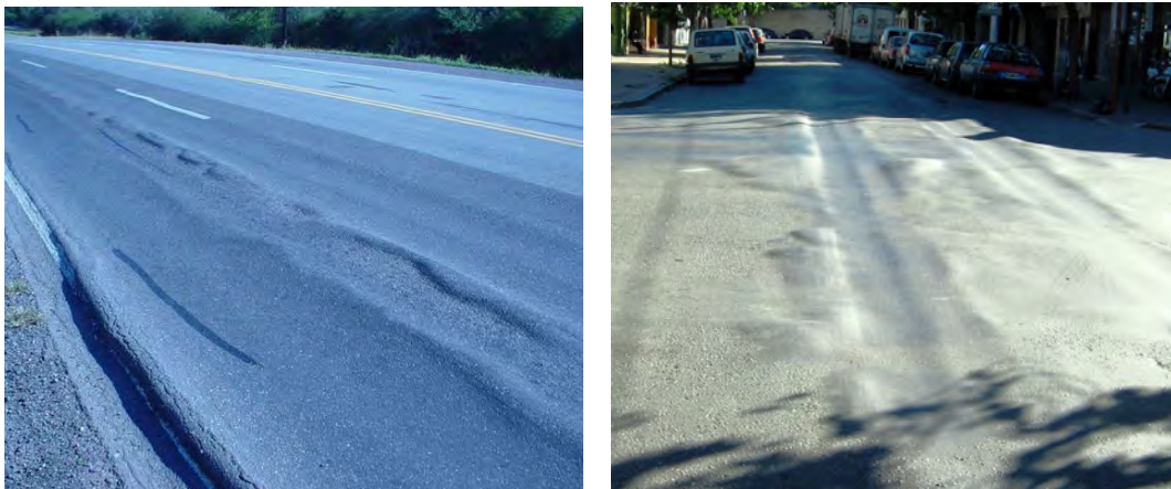
Figura 2.2. Deformaciones permanentes.
