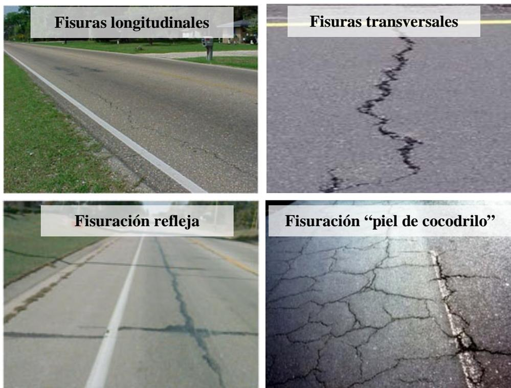
Figura 2.1. Tipos de fisuración en pavimentos asfálticos.
