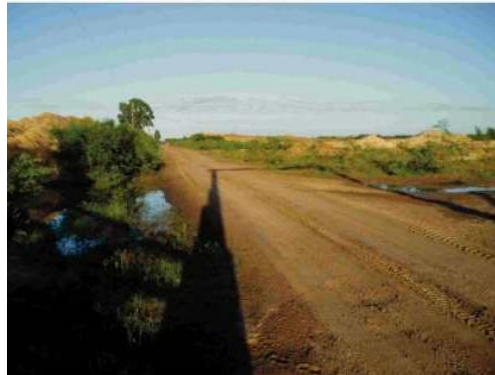
Figura 11. Estado de los caminos internos
