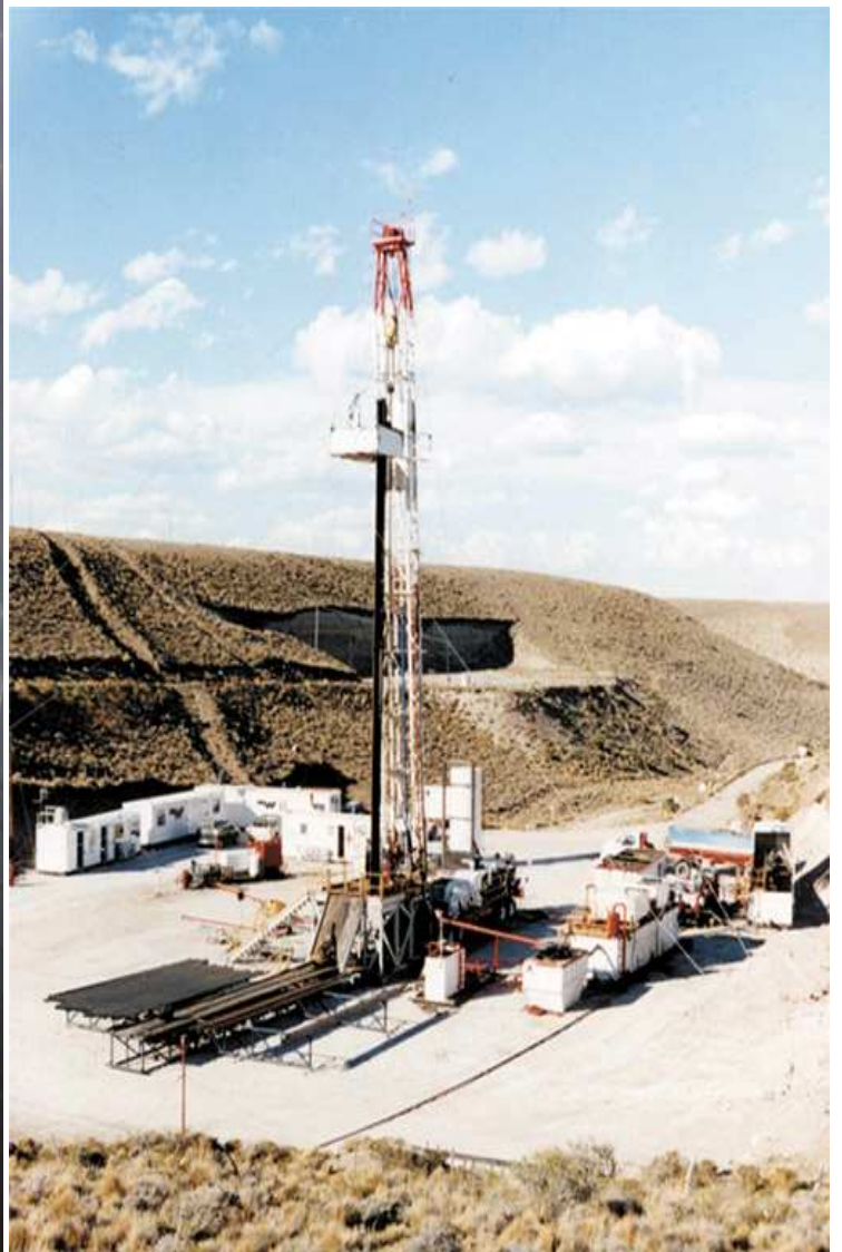
Vista de un sector donde se trabaja. Se puede observar la torre y los trailers.
