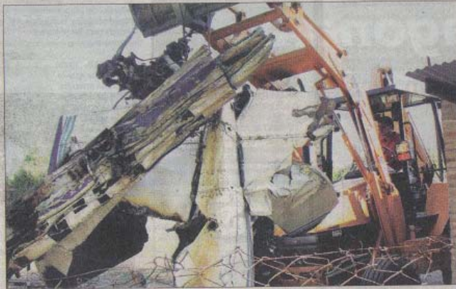
Una pala mecánica retira del predio arbolado los restos del Cessna 180
