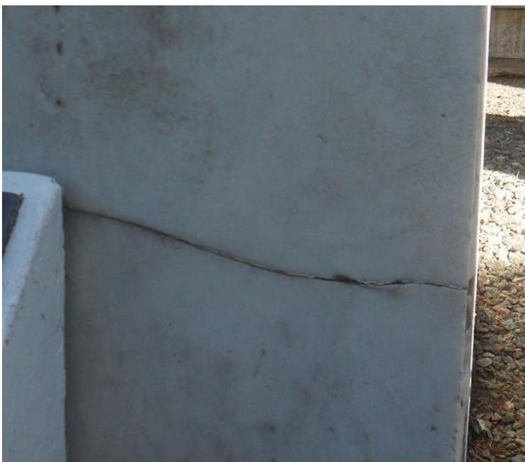
Figura 14. Monumentos a Cornelio Saavedra. Fisuras estructurales. Fuente: elaboración propia.
