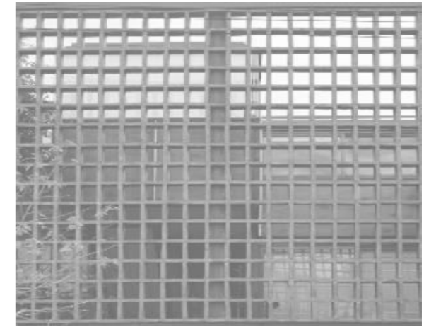
Envolvente-sistema curtain Wall con cámara de aire
