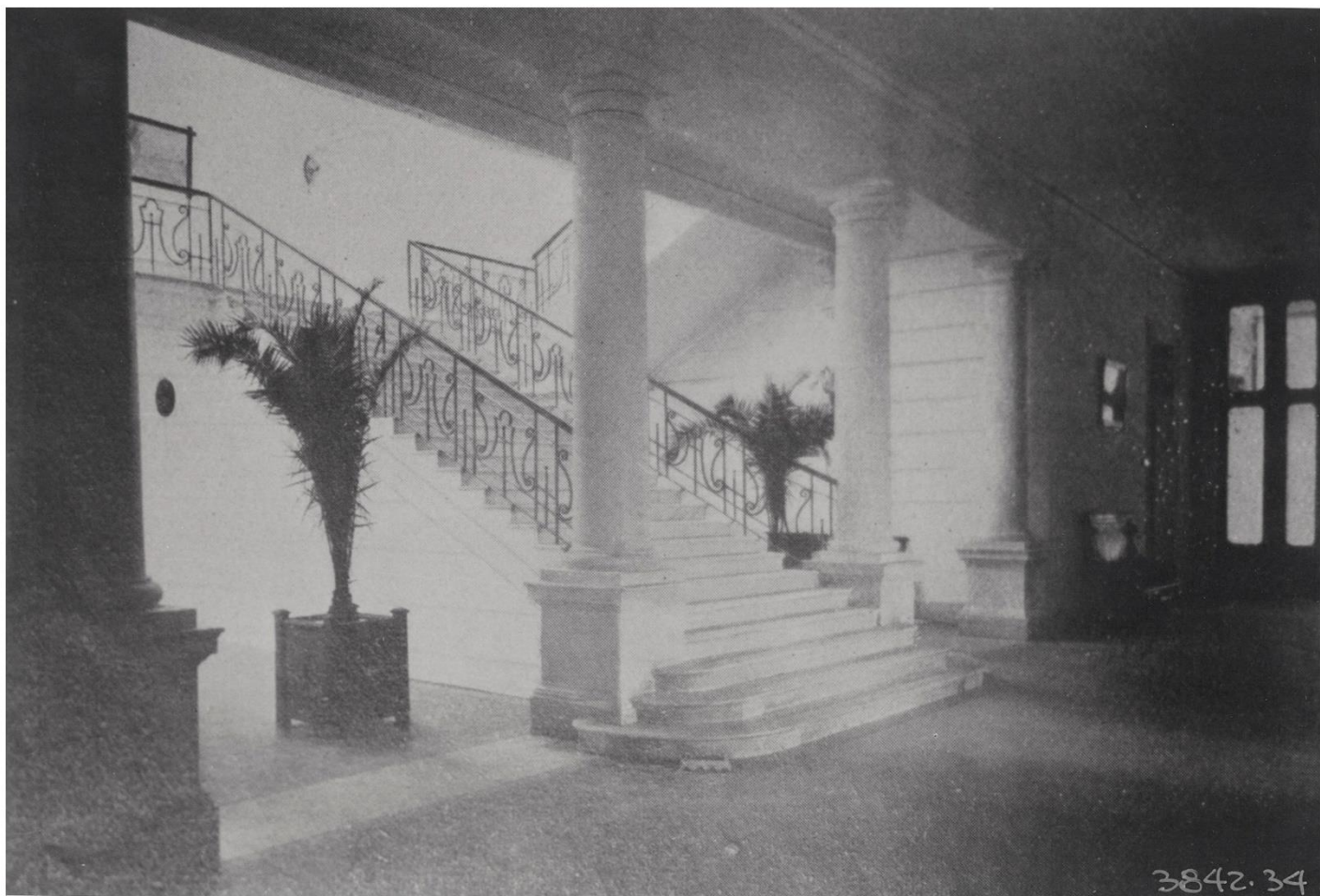
ESCALERA PRINCIPAL DESDE GALERIA EN PLANTA BAJA
