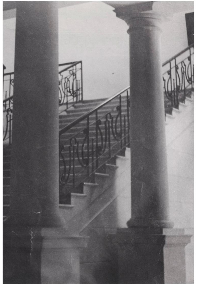
ESCALERA DESDE GALERIA EN PLANTA BAJA
