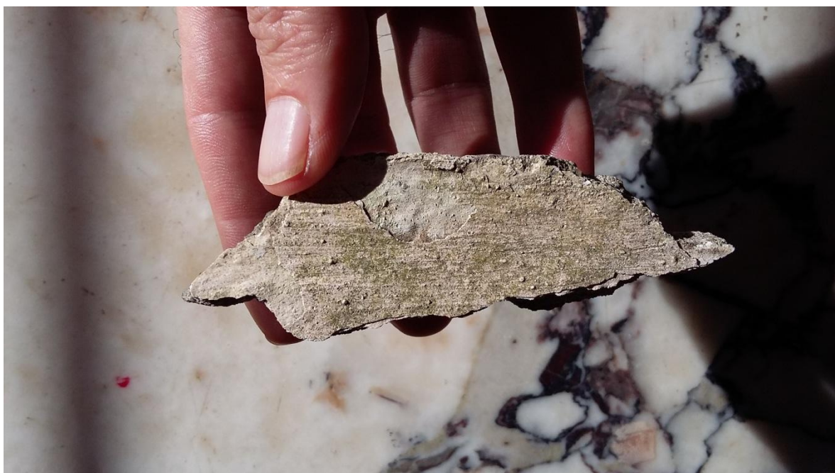
Figura N° 68 Muestra del revoque original de la Casa Robette
