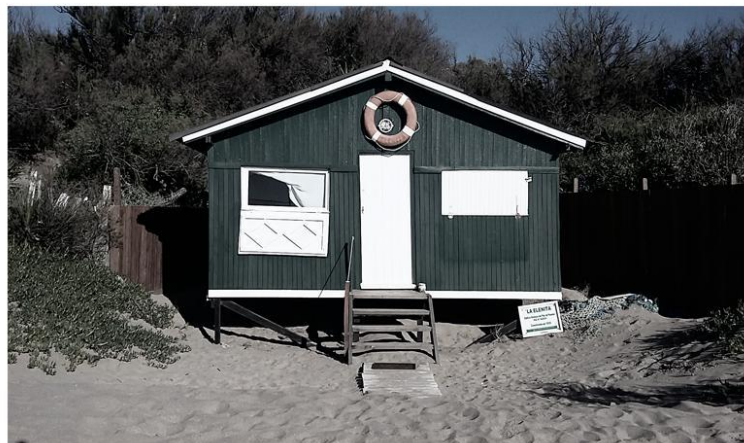
Costruida sobre pilotes, representa una adecuada forma de permitir el libre movimiento de las dunas
