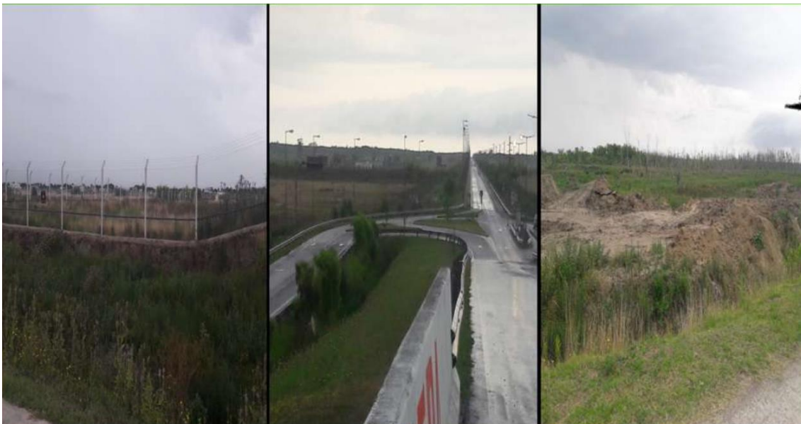
Figura 3. Imágenes del perímetro de Avenida 63
