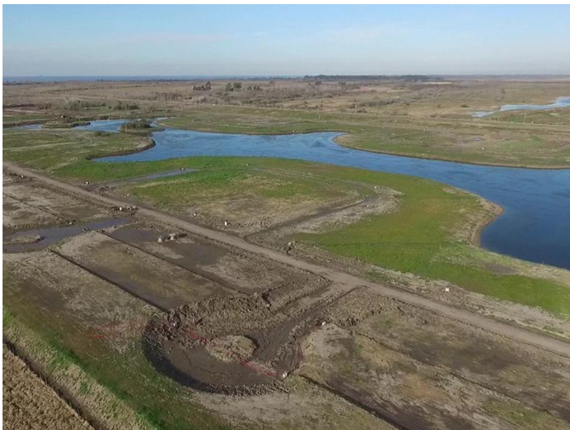
Figura 4. Construcción del barrio Sebastián Elcano – Proyecto Pueblos del Plata
