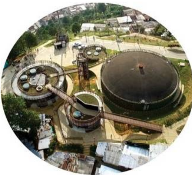
Intervencion de tanques en medellin
