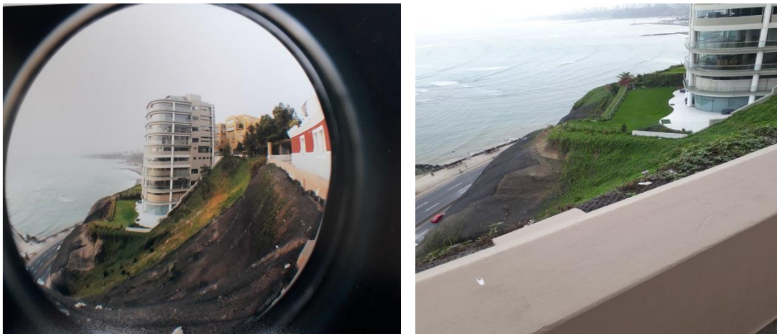
Imagen 4: Edificio Aquamarina construido irregularmente sobre el acantilado
