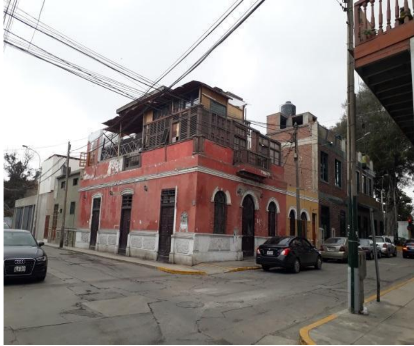
Imagen 3: Casa deteriorada Barranco
