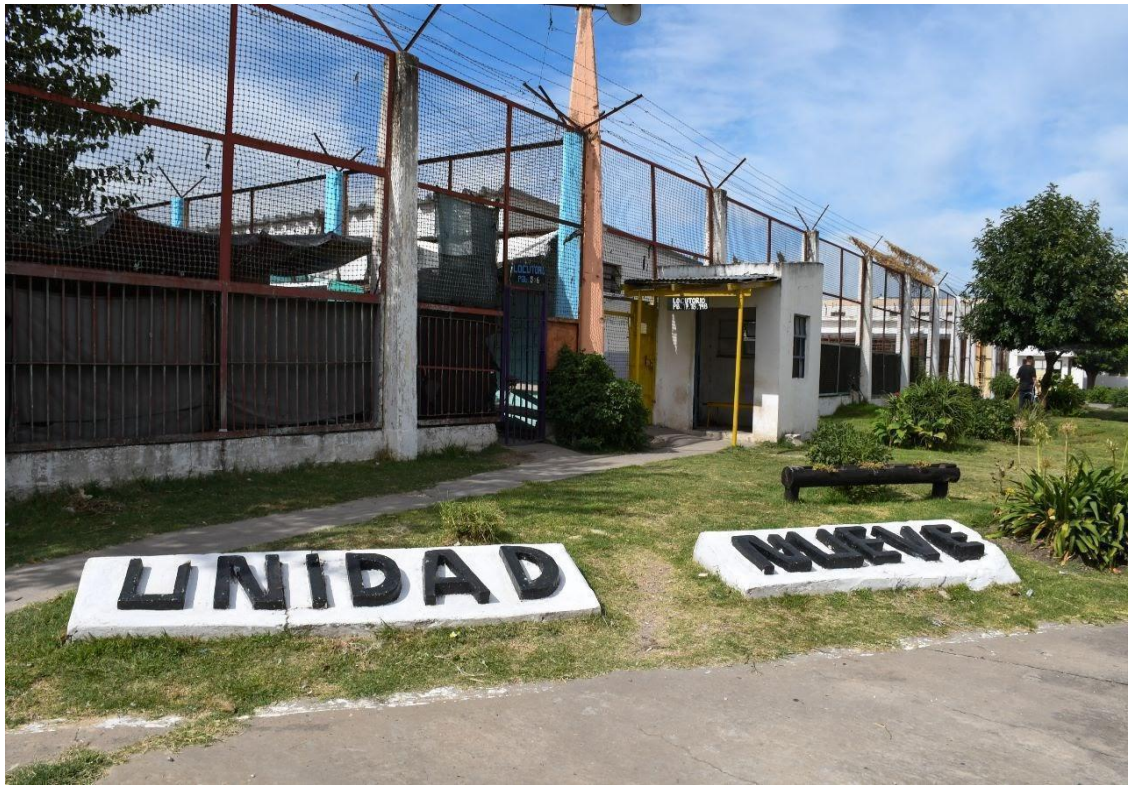
Imagen 3. UP9. Vista desde el patio corredor interno derecho, 2021.
