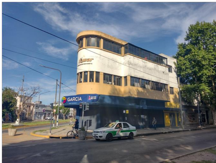
Esquina de 1 y 60 en la actualidad, donde en el segundo piso funcionaba el teatro del Bosque. (Foto: Victoria Balaguer)
