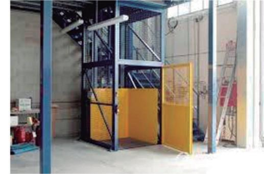
Al ser un edificio de baja altura, se opta por ascensores hidráulicos, por la posibilidad de no tener sala de máquinas sobre los ascensores, además de ser más seguros. Además de los ascensores, habrá un montacargas, también hidráulico, que irá desde el depósito en el sótano hasta el multiespacio en planta baja.
