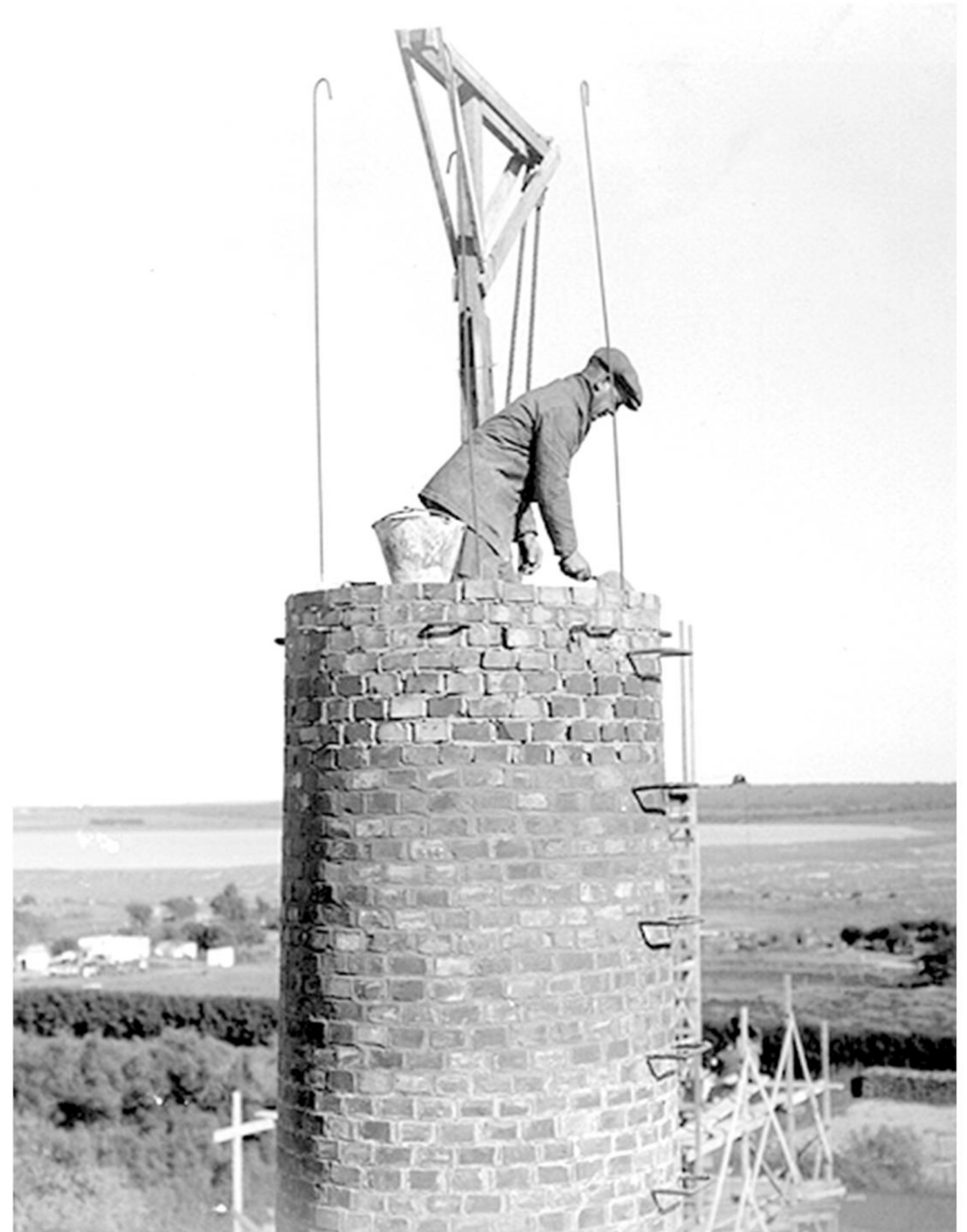
1- Construcción del Molino Werner, 1902
