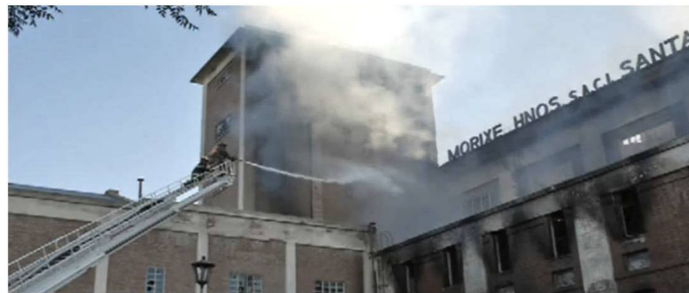
13- Molino Werner, 1950 14- ex Molino Werner, 2018 15- Incendio en sector de molienda, 2010
