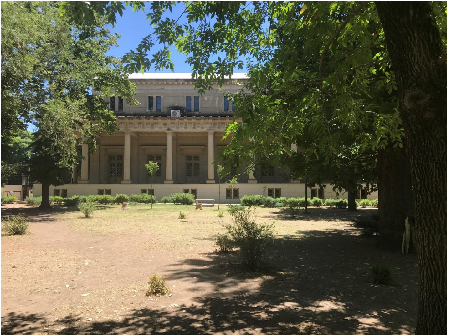
PARTENON – ESTADO ACTUAL (VISTA SURESTE)
