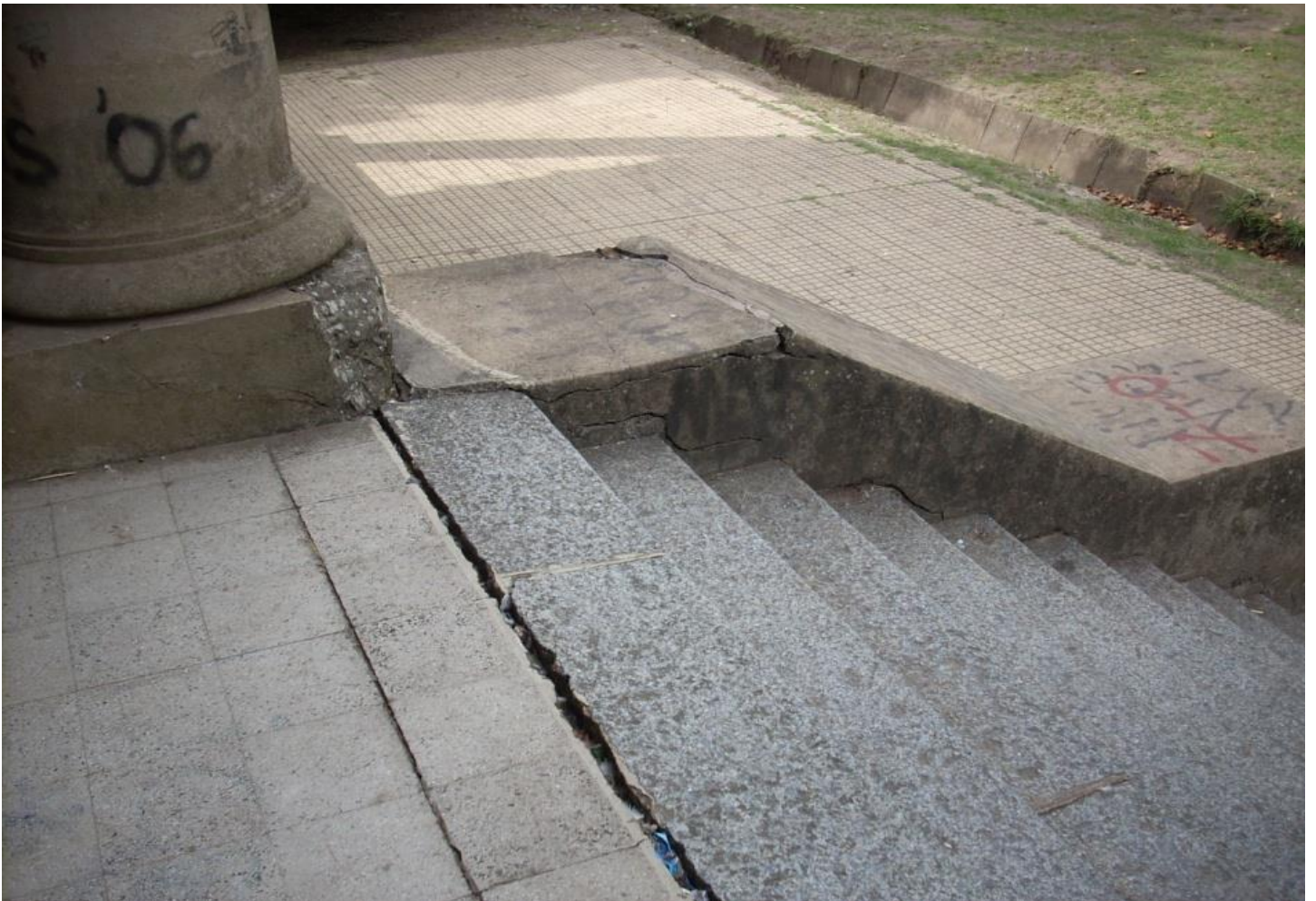
PARTENON – ESTADO PREVIO A LA RECUPERACION (ACCESO)
