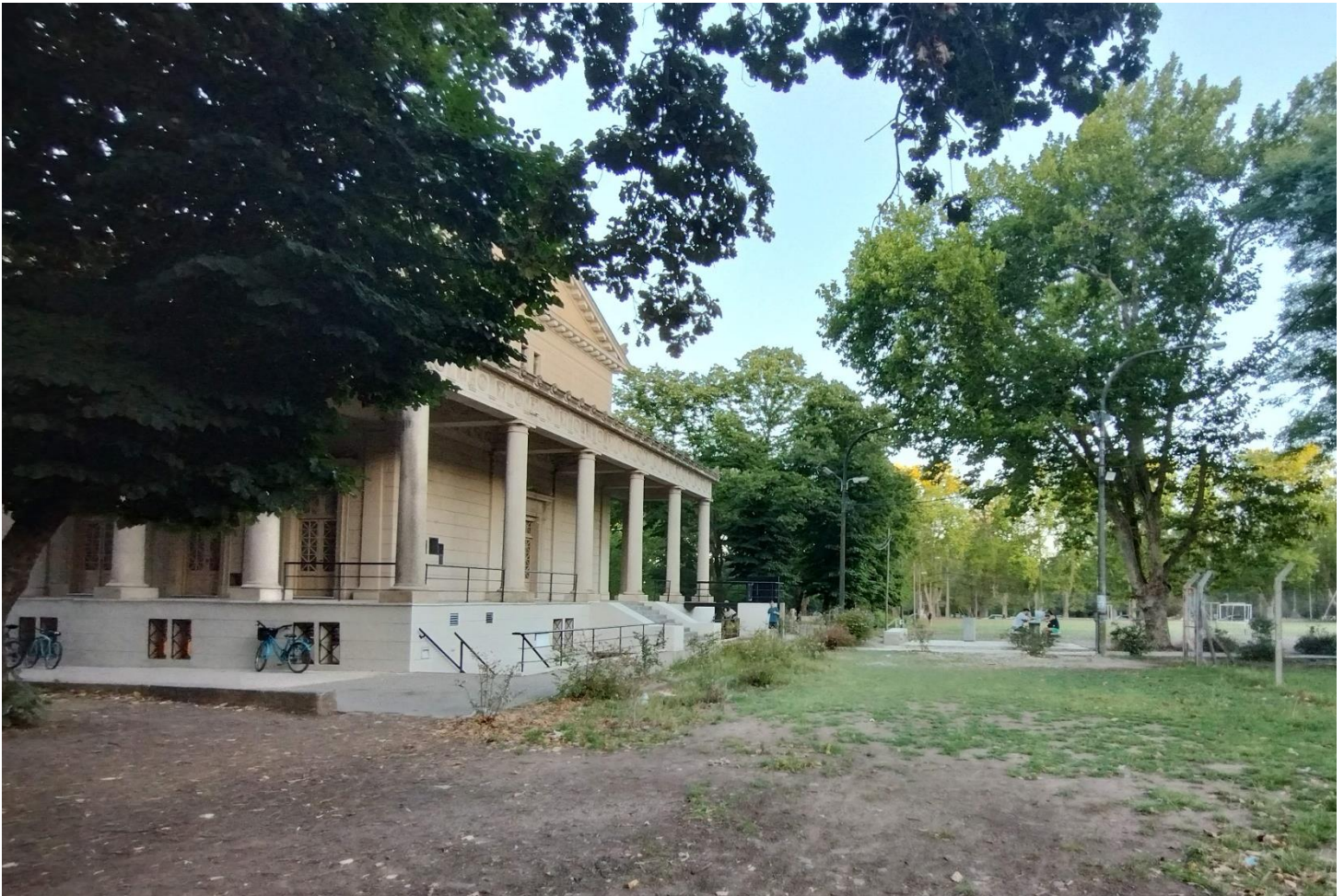
PARTENON – ESTADO ACTUAL (VISTA NOROESTE)
