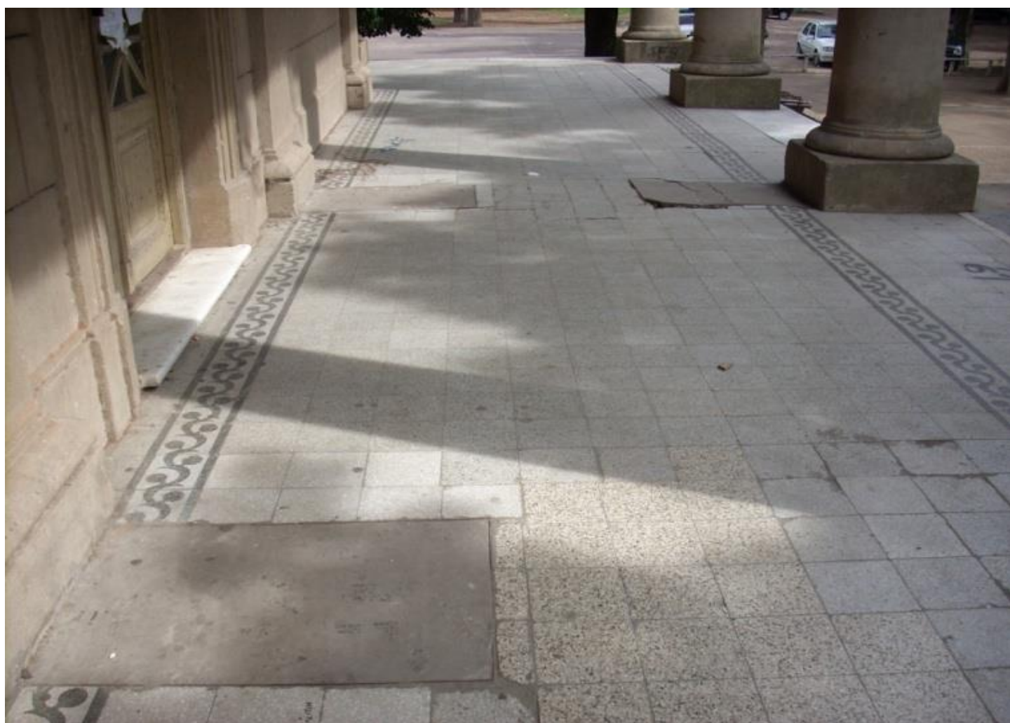
PARTENON – ESTADO PREVIO A LA RECUPERACION (SOLADOS EN GALERIAS)
