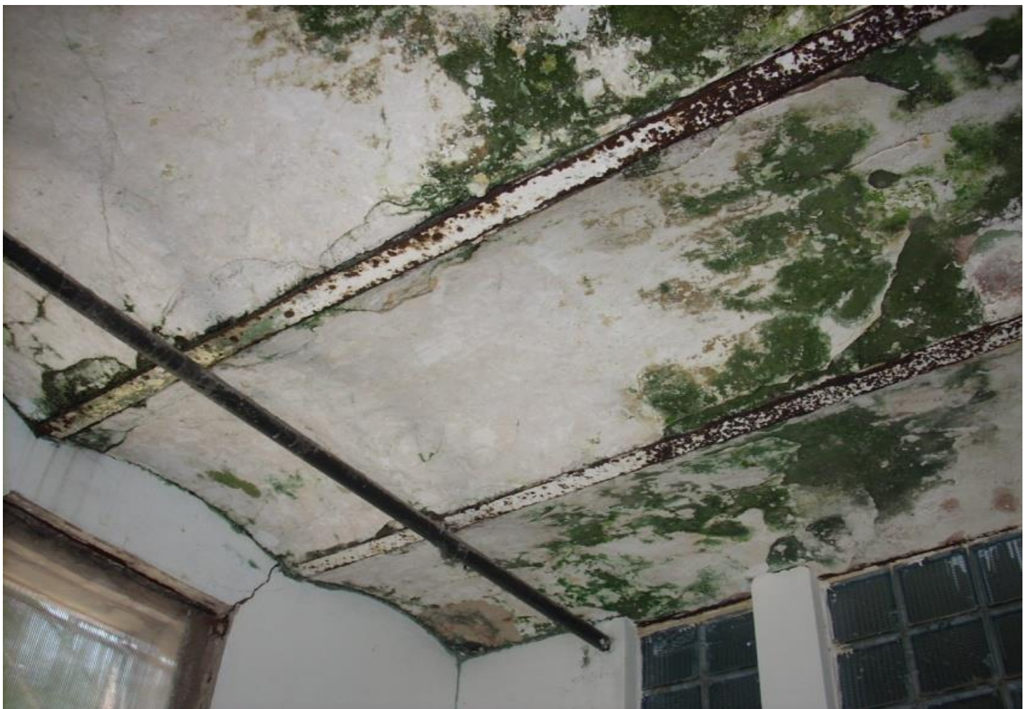
PARTENON – ESTADO PREVIO A LA RECUPERACION (SUBSUELOS)
