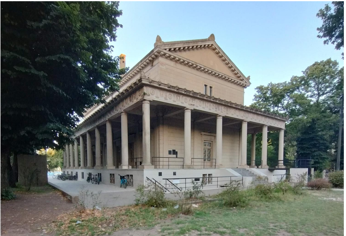
PARTENON – ESTADO ACTUAL (VISTA ESTE)
