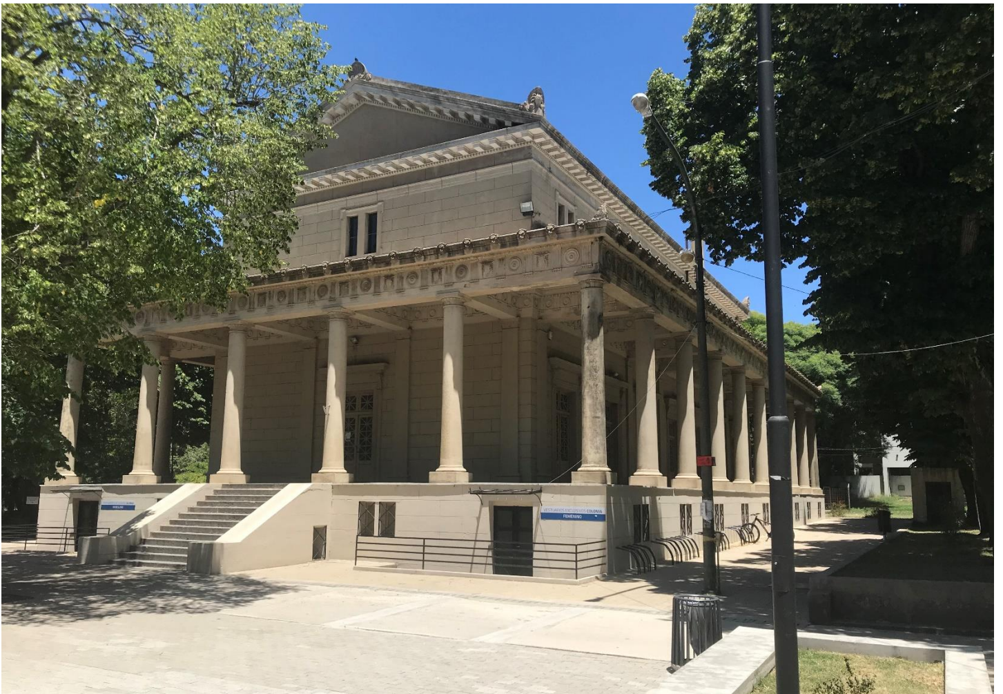
PARTENON – ESTADO ACTUAL (ESQUINA NORTE)
