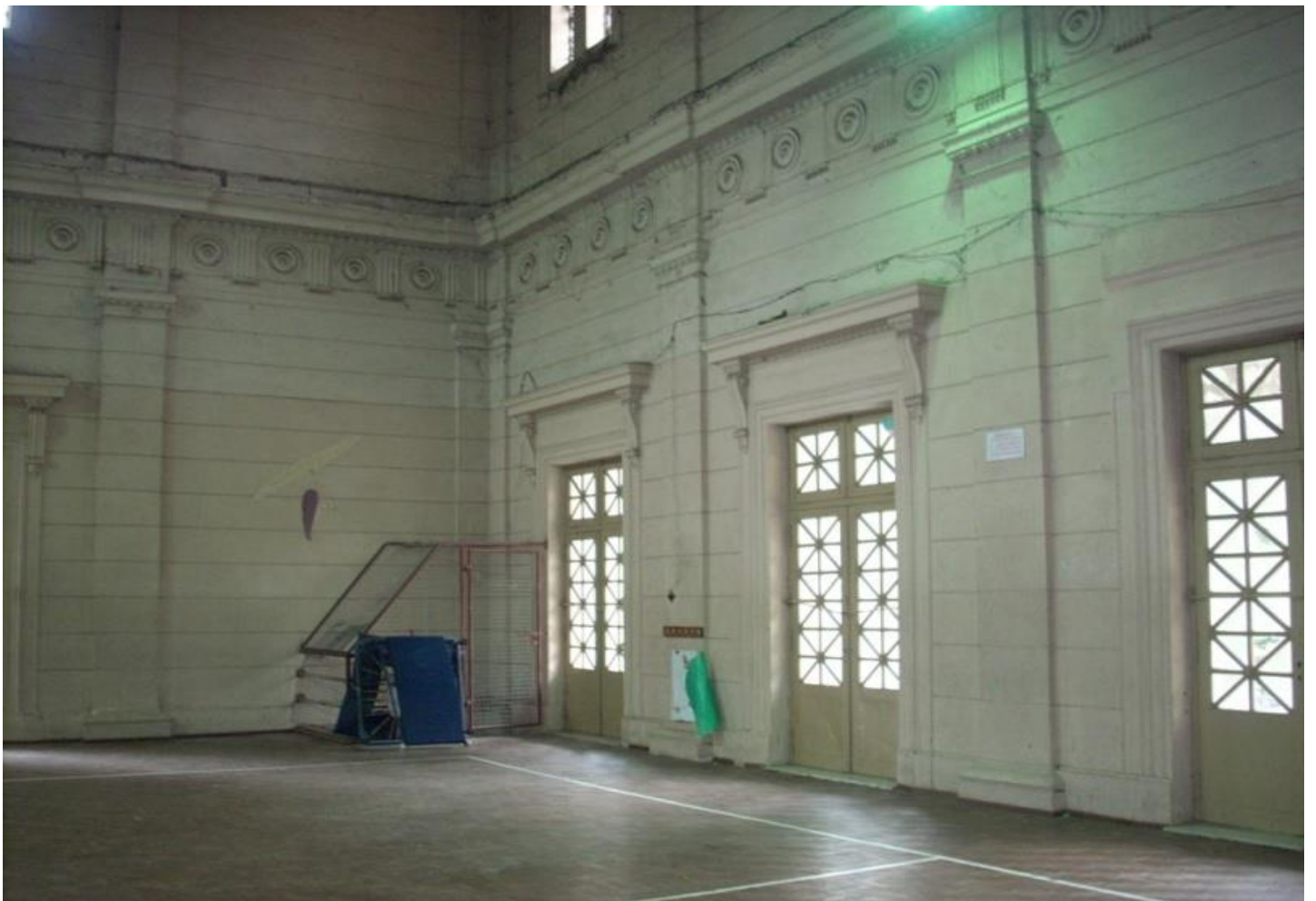
PARTENON – ESTADO PREVIO A LA RECUPERACION (SALÓN PRINCIPAL)
