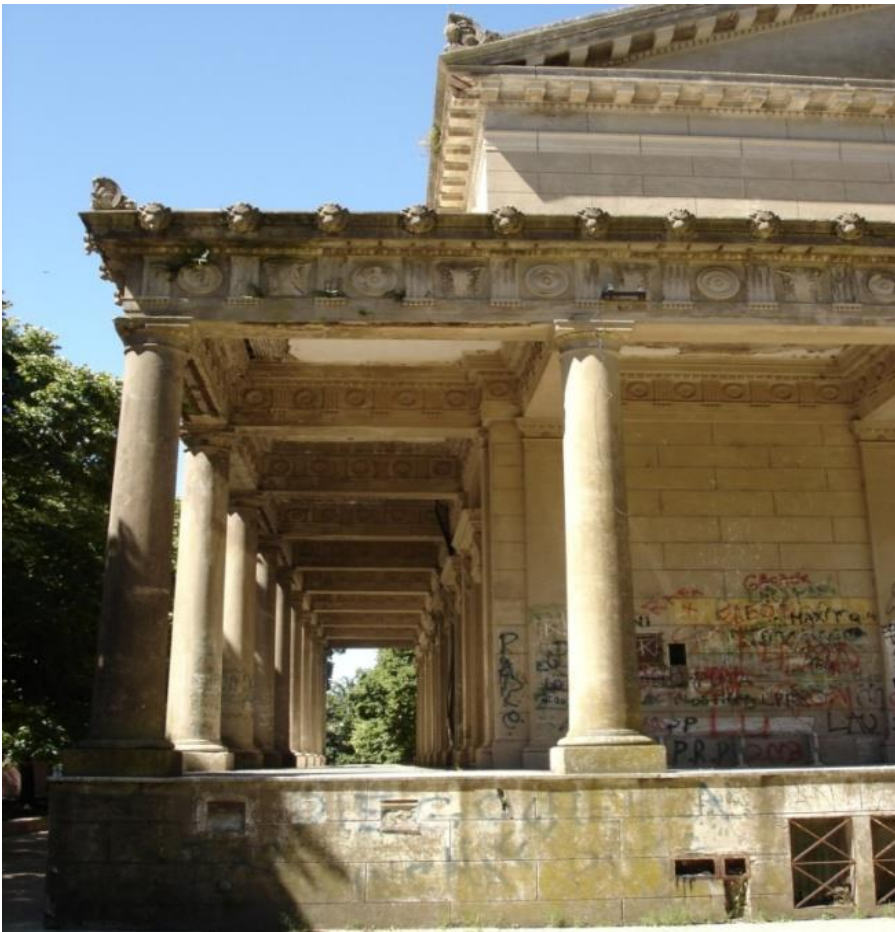
PARTENON – ESTADO PREVIO A LA RECUPERACION (GALERIA SUROESTE)
