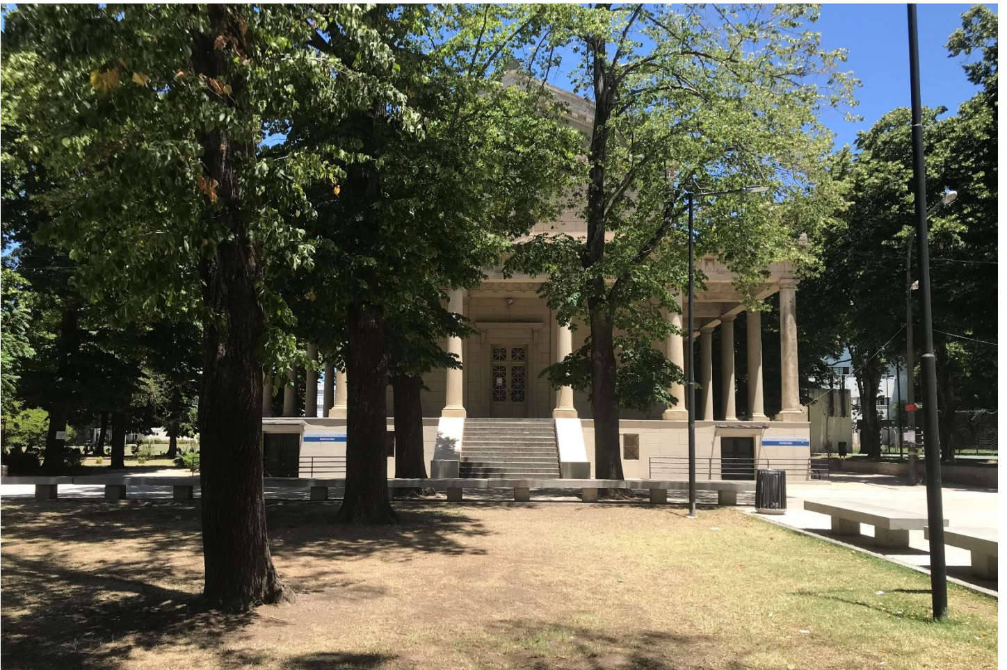
PARTENON – ESTADO ACTUAL (VISTA NORESTE)
