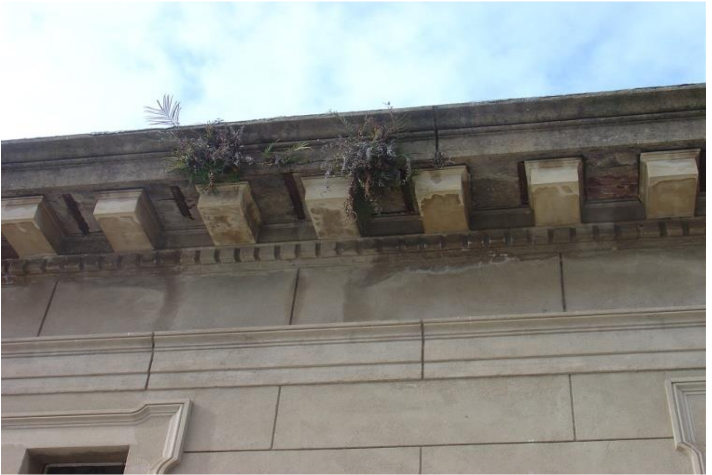
PARTENON – ESTADO PREVIO A LA RECUPERACION (CORNISAS)
