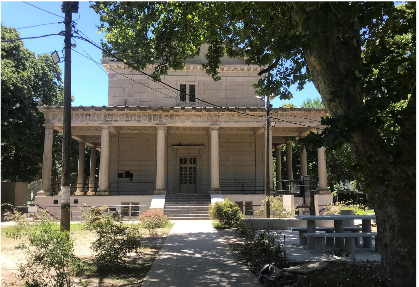
PARTENON – ESTADO ACTUAL (VISTA NOROESTE)
