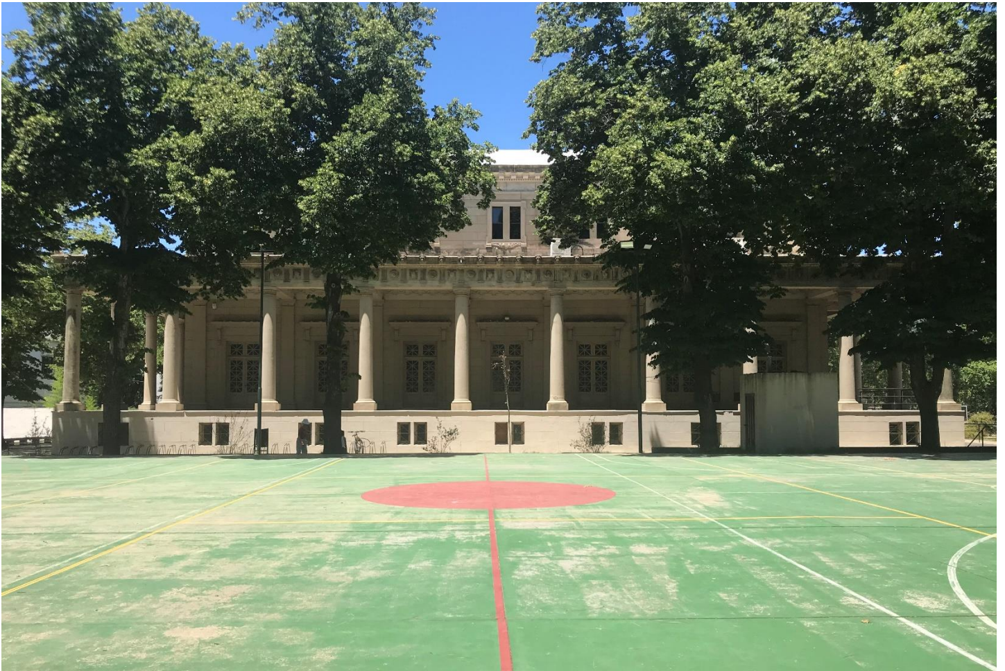
PARTENON – ESTADO ACTUAL (DETALLES DE FACHADA)
