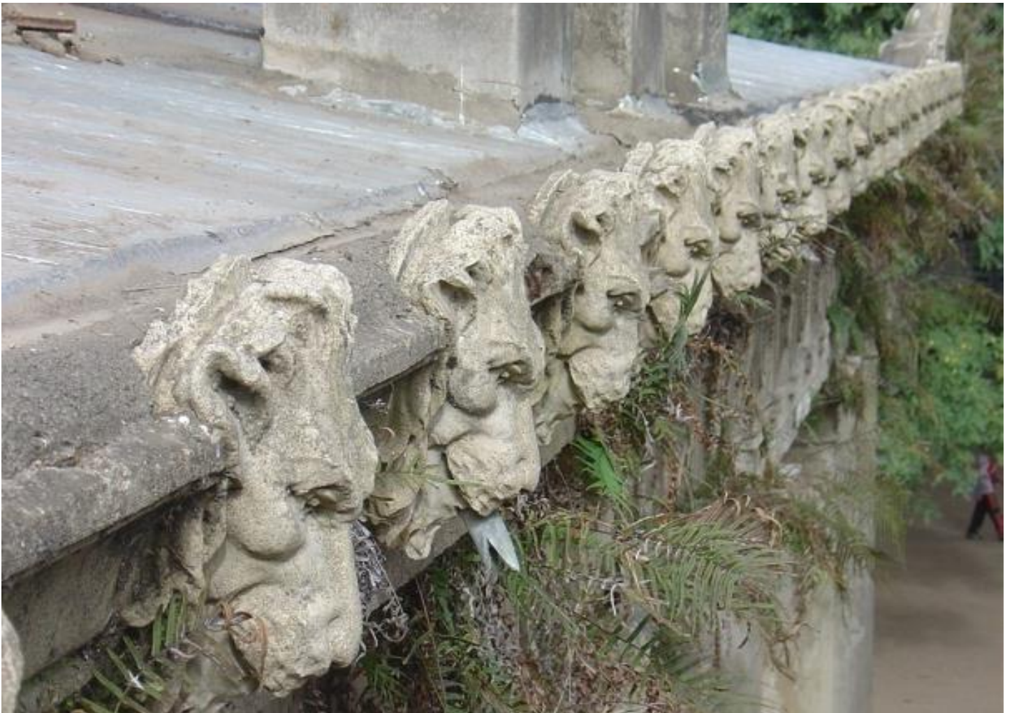
PARTENON – ESTADO PREVIO A LA RECUPERACION (ORNAMENTOS)
