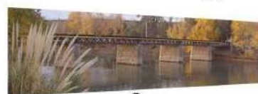
(F) PUENTE CARRETERO LA PAMPA- RIO NEGRO
