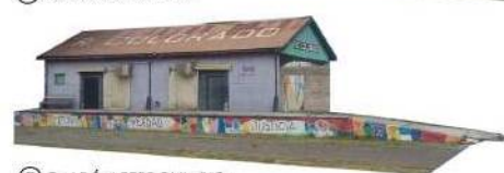
(E) GALPÓN FERROVIARIO
