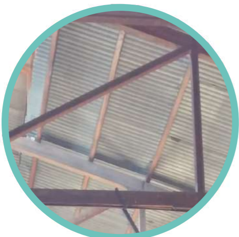
Cubierta gris de chapa Galvanizada.
