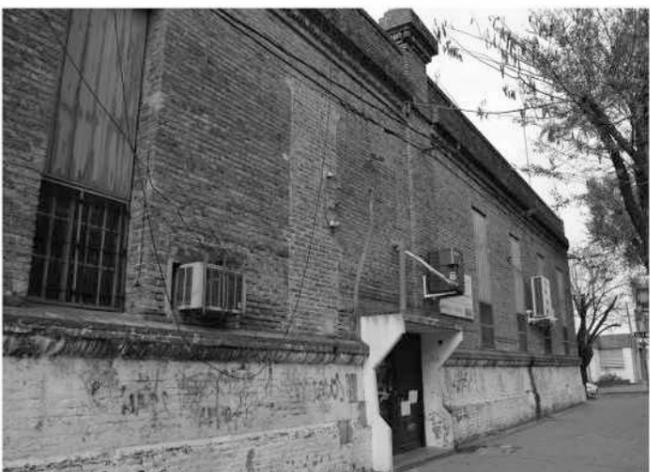
La envolvente compuesta por un muro de ladrillo macizo a la vista, se encuentra interrumpida en todo su perímetro por aberturas e instalaciones de distinto tipo. Presenta lesiones físicas (**humedad y suciedad**), mecánicas (**fisuras y desprendimientos**) y químicas (**eflorescencias**). En la mayoría de los casos corresponden a falta de mantenimiento y a una clara ausencia de proyecto a la hora de intervenir por sobre lo construido.
