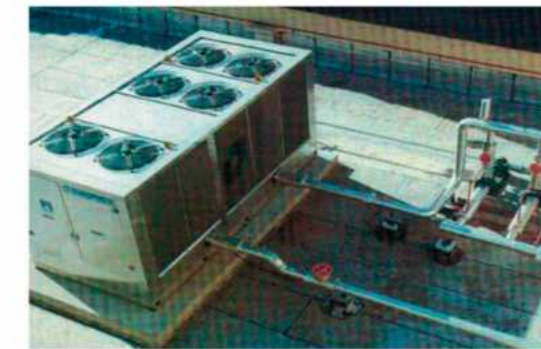
Máquina enfriadora de líquidos (MEL) condensada por aire, puede traer un kit hidráulico
