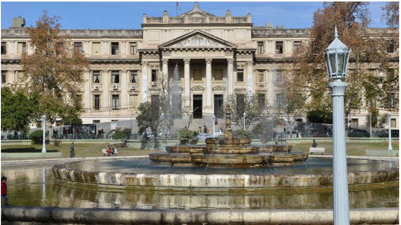
Fig.3 Fachada del Palacio de Tribunales de Córdoba
