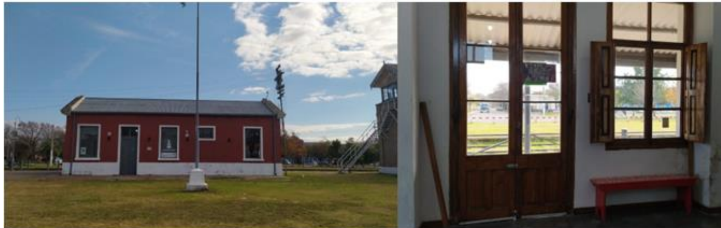
Figura 2: Entrada del edificio comunal y detalle interior hacia el andén. Fuente: Propia, 2022.
