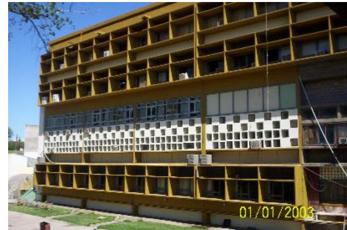
Municipalidad de La Pampa. Clorinda Testa.
