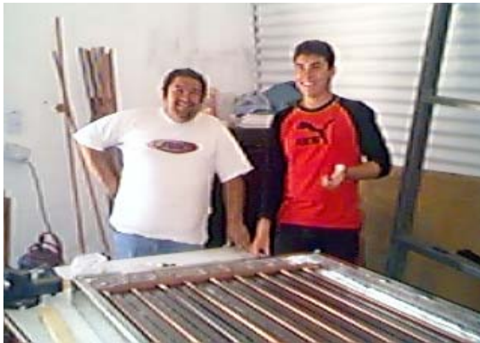
Autoconstrucción de colectores solares planos
