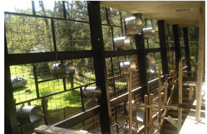
Detalle de la estructura desde el interior
