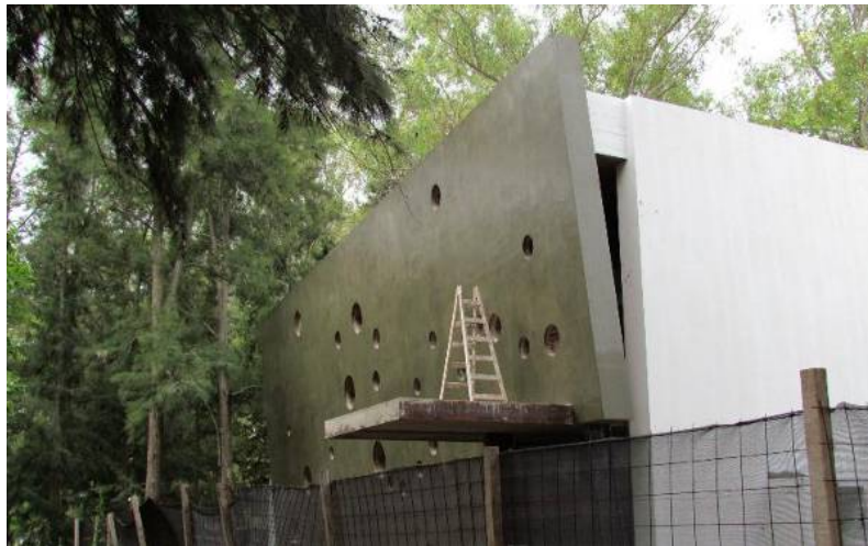
Detalle de Fachada en construcción
