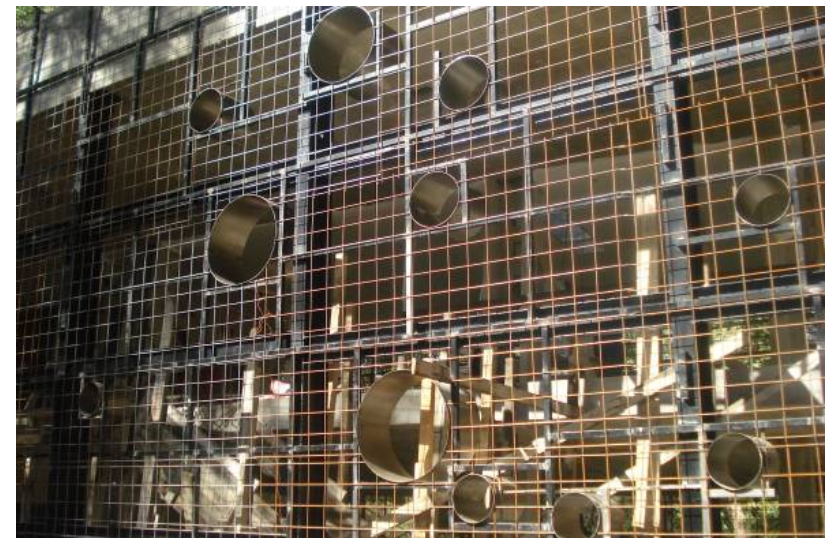
Detalle de la estructura desde el exterior
