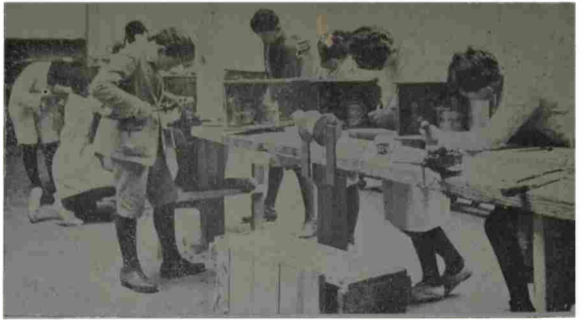
ILUSTRACION Nº 8 CONSTRUCCION DE RECEPTORES DE RADIO-TELEFONIA. Un aspecto del aula-taller, donde las mesas de trabajo fueron improvisadas con los tablones utilizados para armar el andamio destinado a levantar el frente del "Taller de Manualidades". En primer término (centro), un alumno asegura las derivaciones de la bobina con el soldador; los otros, que ya terminaron la construcción de la caja del receptor, colocan las piezas y accesorios.
