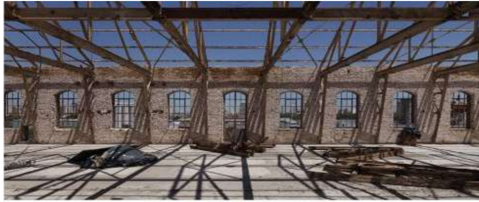
Estado del edificio antes del proyecto
