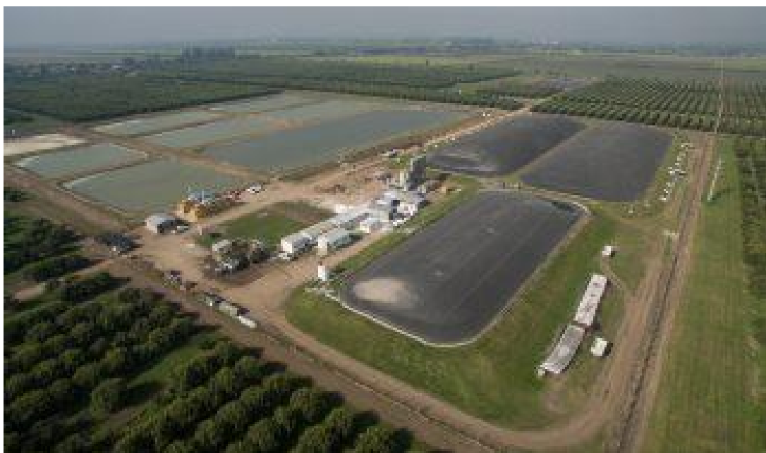
Figura 1.9: Piletas de tratamiento por lote de efluentes. Sistema Hídrico cerrado. Fuente: Planta de empaquetamiento Citrusvil
