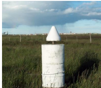
Figura 10. Estación permanente GPS de Río Grande.
