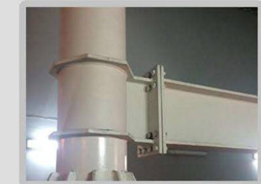
Unión columna y viga de entrepiso
