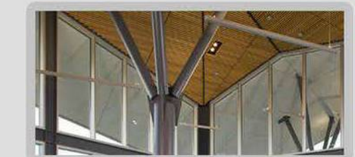
Ramificación de columna metálica
