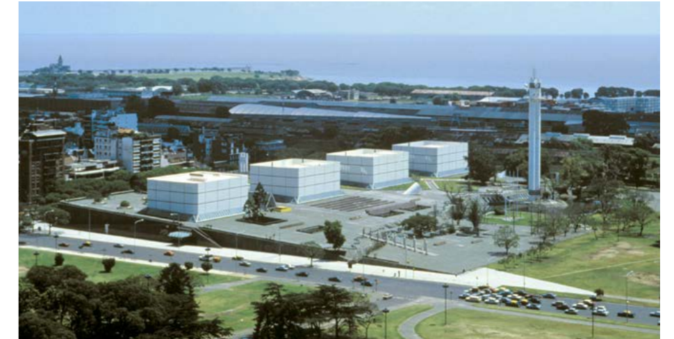
ATC - (actual sede de TV Pública) - C.A.B.A. 1978 - Arq. M/SG/S/S/S
