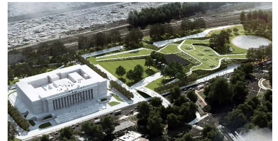
Centro de Exposiciones y Convenciones - C.A.B.A. 2013 - Arq. Edgardo Minond.
