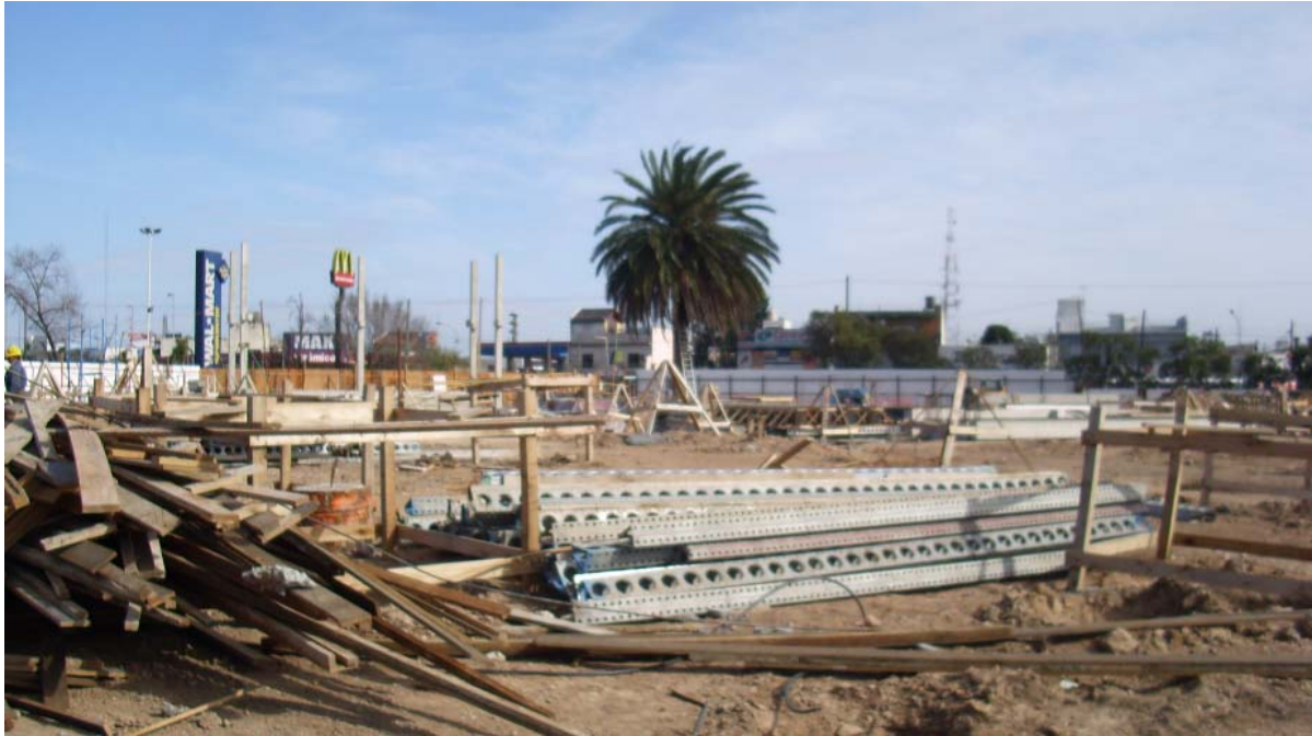
Figura 5.1: Vista del obrador con la centenaria palmera que sobrevivió a la tala masiva.
