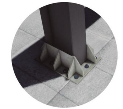
La estructura metálica es protegida con pintura intumescente monocomponente al agua y luego es terminada con pintura de poliuretano para lograr el color que se quiere.
