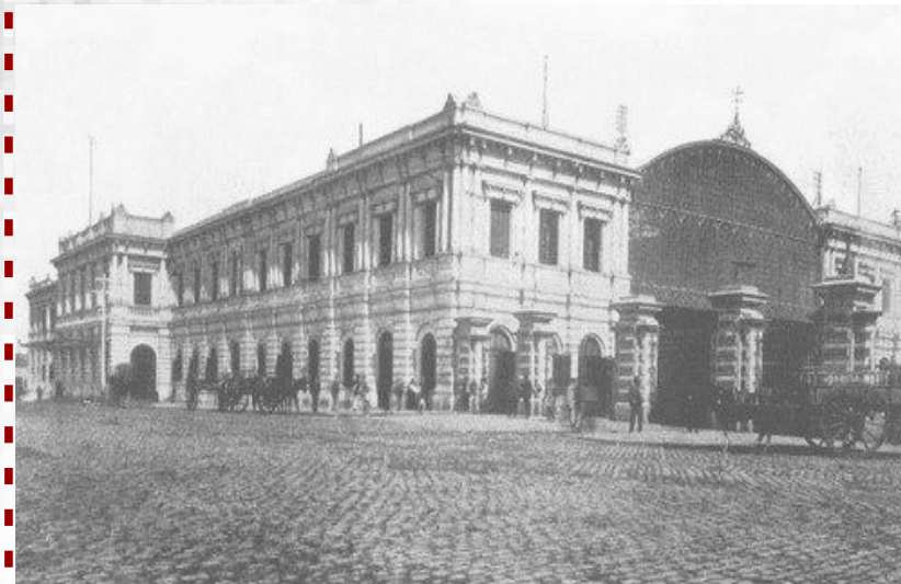
ESTACIÓN 19 DE NOVIEMBRE
