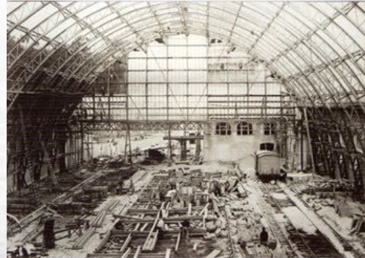
2-CONSTRUCCIÓN ESTACIÓN LA PLATA NAVE DE TRENES
