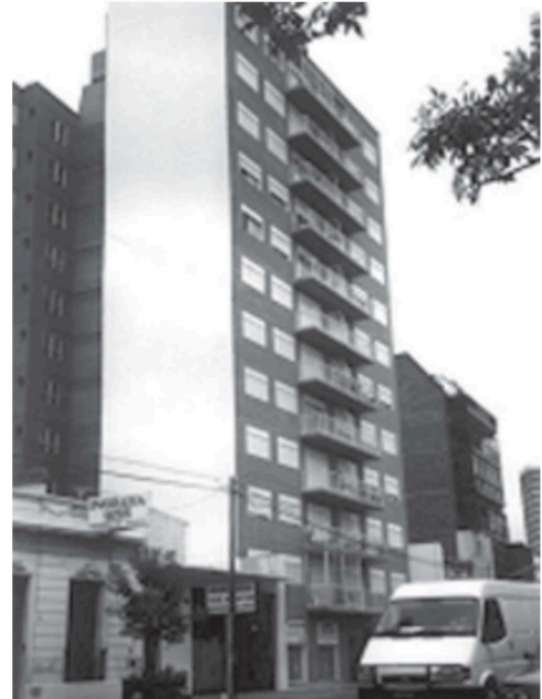
FIGURA 11: Vista del edificio de la Cooperativa Grand Bourg (Avellaneda). 1999. Fuente: PMH, FADU, UBA.
