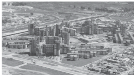
FIGURA 1: Vista general del Conjunto Urbano Soldati. 1981. Fuente: Comisión Municipal de la Vivienda.
