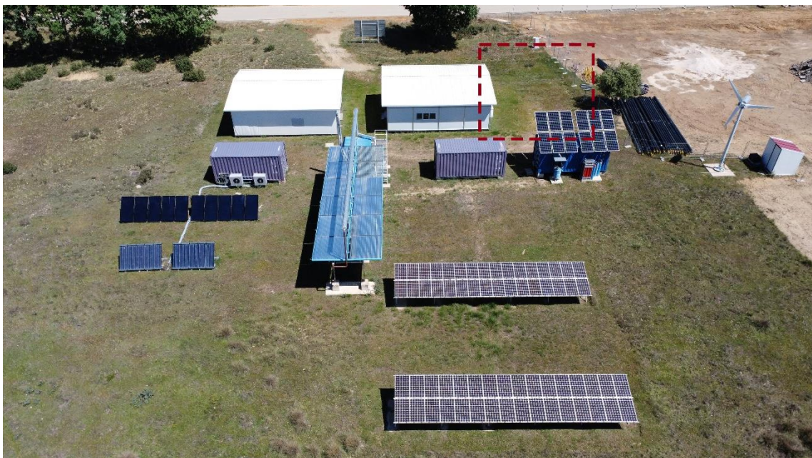
Fig. 1. Ampliación en módulo habitacional
