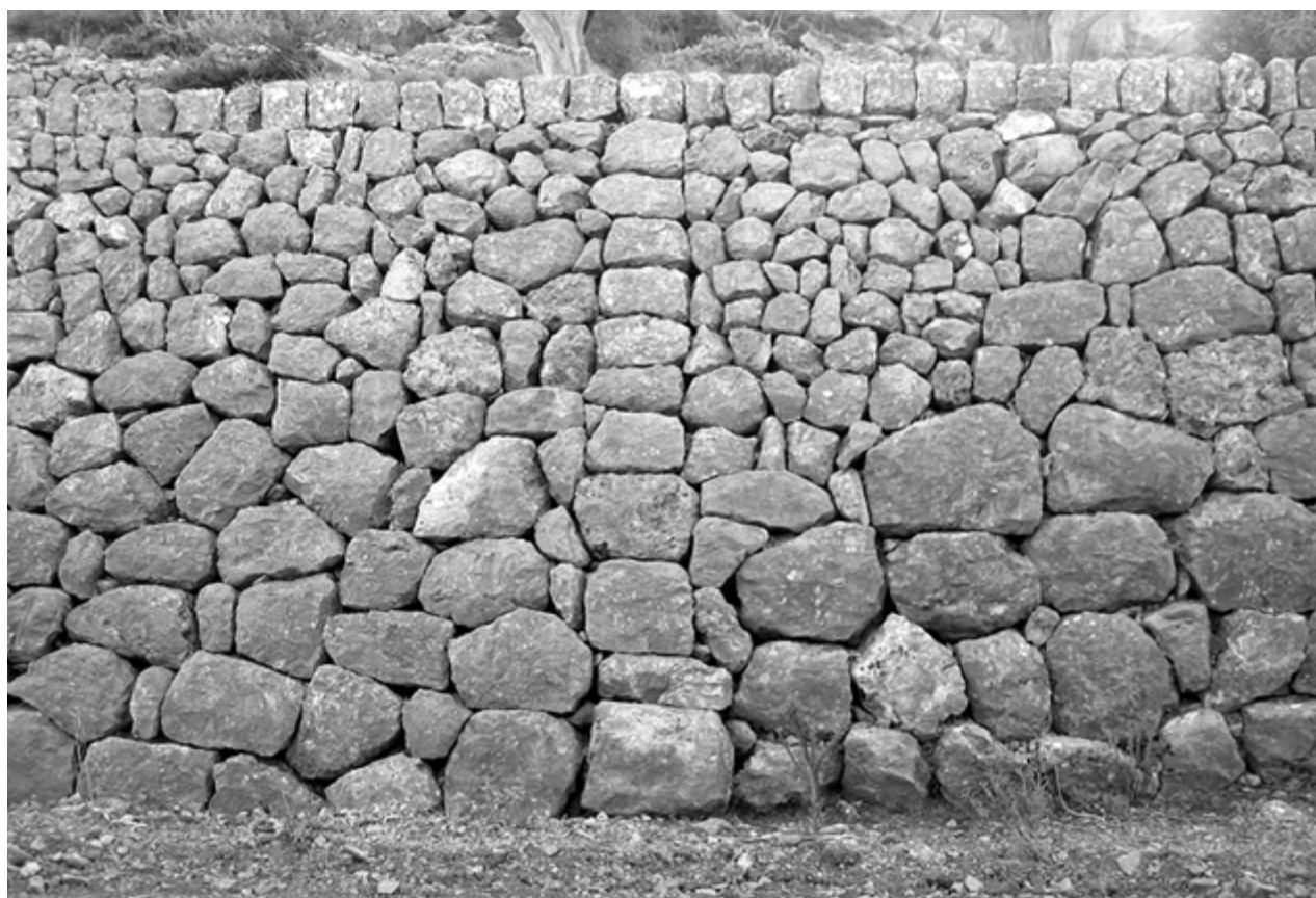
Figura 1. Bancal rehecho con capginya, Sóller, Mallorca
