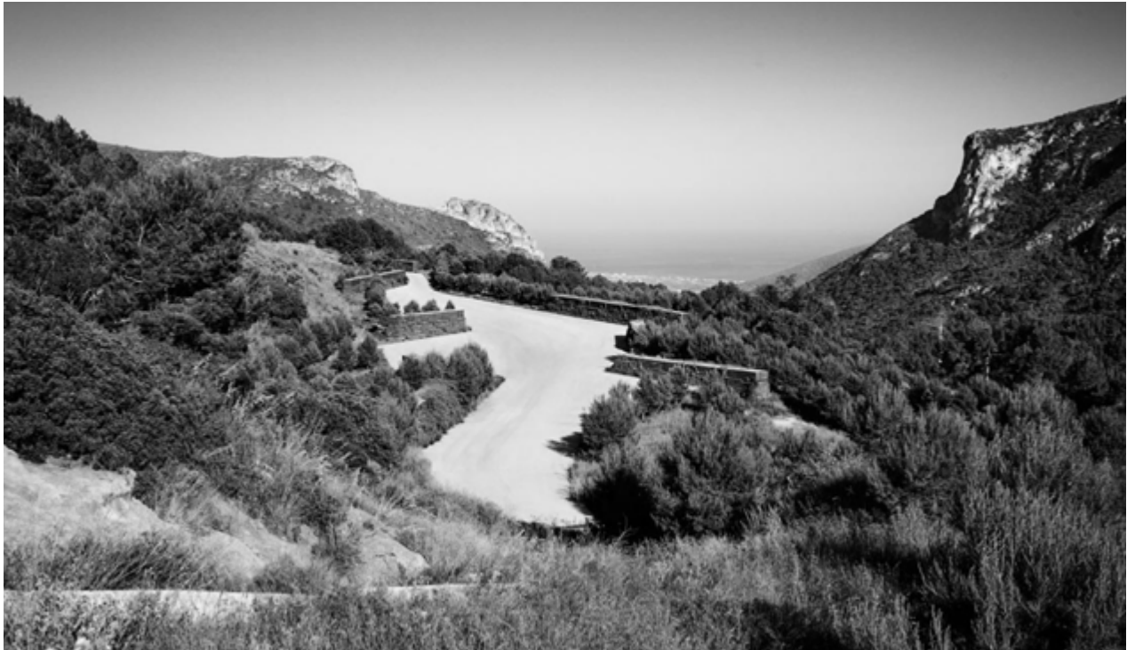
Figura 8. Acceso al Vertedero del Garraf con los muros de gaviones
