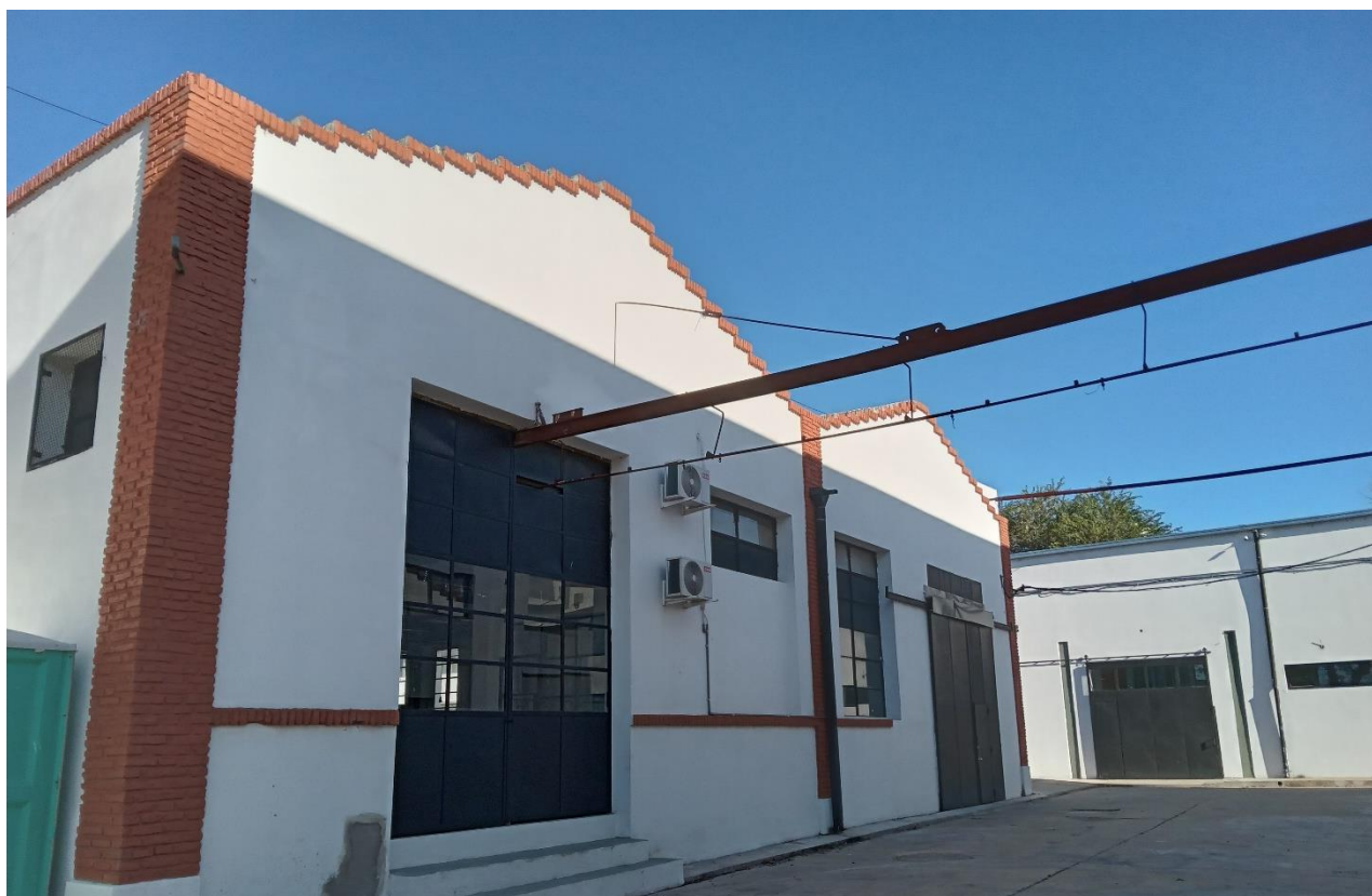
CIAAA- EDIFICIO de ENSAYOS / CONDICIÓN PREVIA Y DURANTE A LA INTERVENCIÓN
