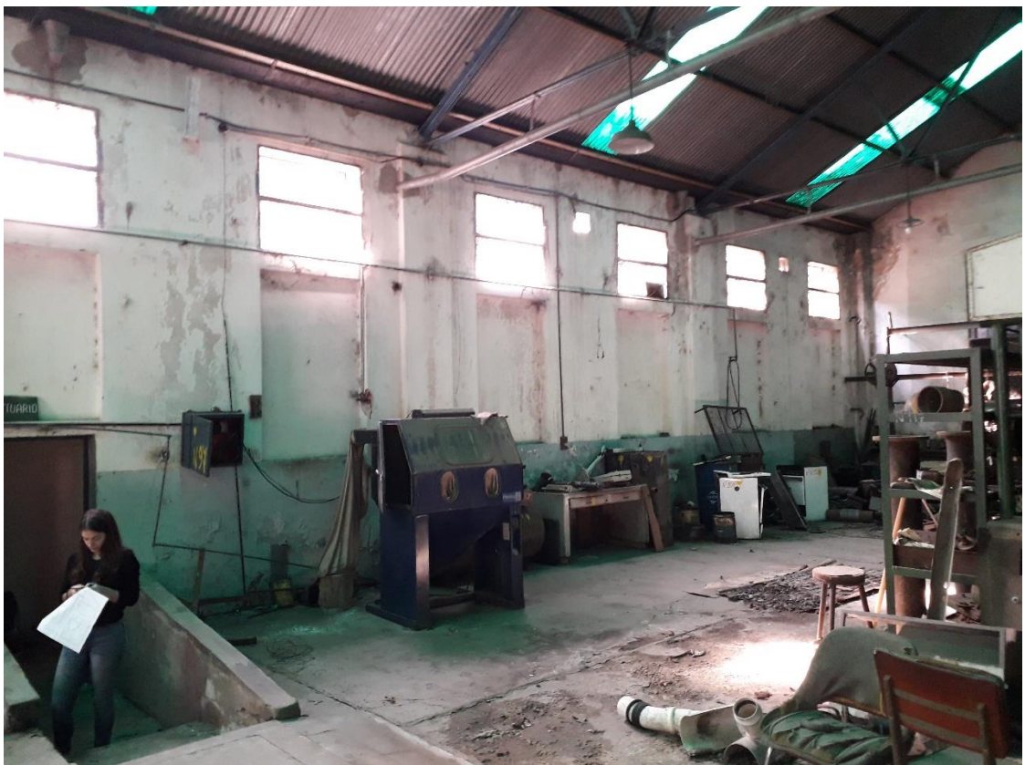
CIIAAA- EDIFICIO de ENSAYOS / CONDICIÓN PREVIA A LA INTERVENCIÓN
