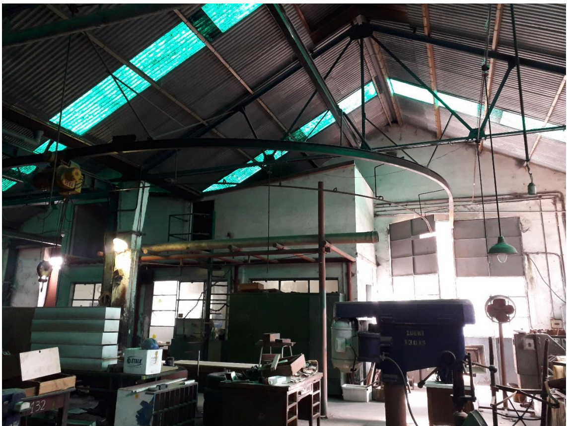
CIAAA- EDIFICIO de ENSAYOS / CONDICIÓN PREVIA A LA INTERVENCIÓN
