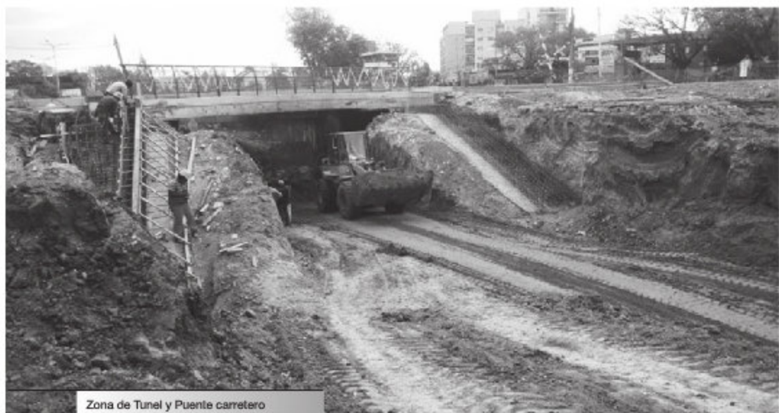
Zona de Tunel y Puente carretero
