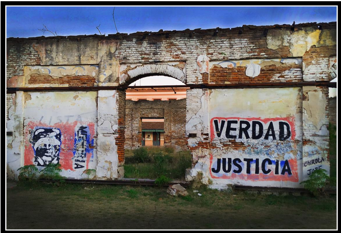
Galpones de la Estación de trenes de Concepcion del Uruguay (E.R.). Imagen propia
