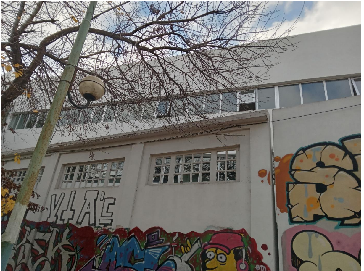
CIIAAA- EDIFICIO de GESTIÓN / FACHADA URBANA
