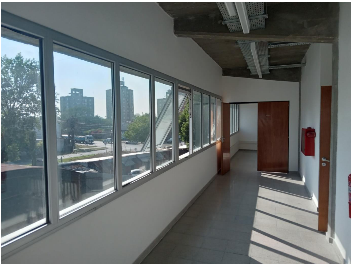
CIIAAA- EDIFICIO de GESTIÓN / INTERIORES
