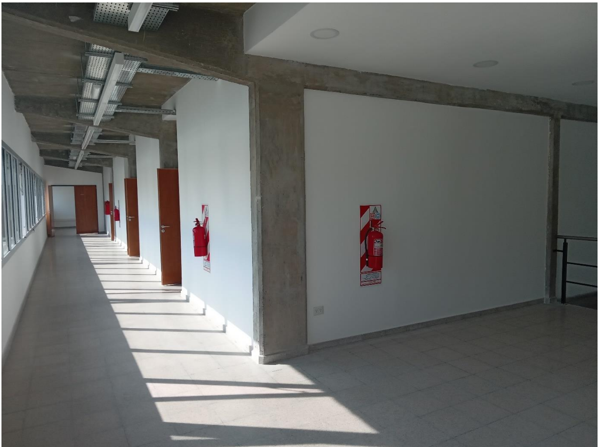
CIIAAA- EDIFICIO de GESTIÓN / INTERIORES
