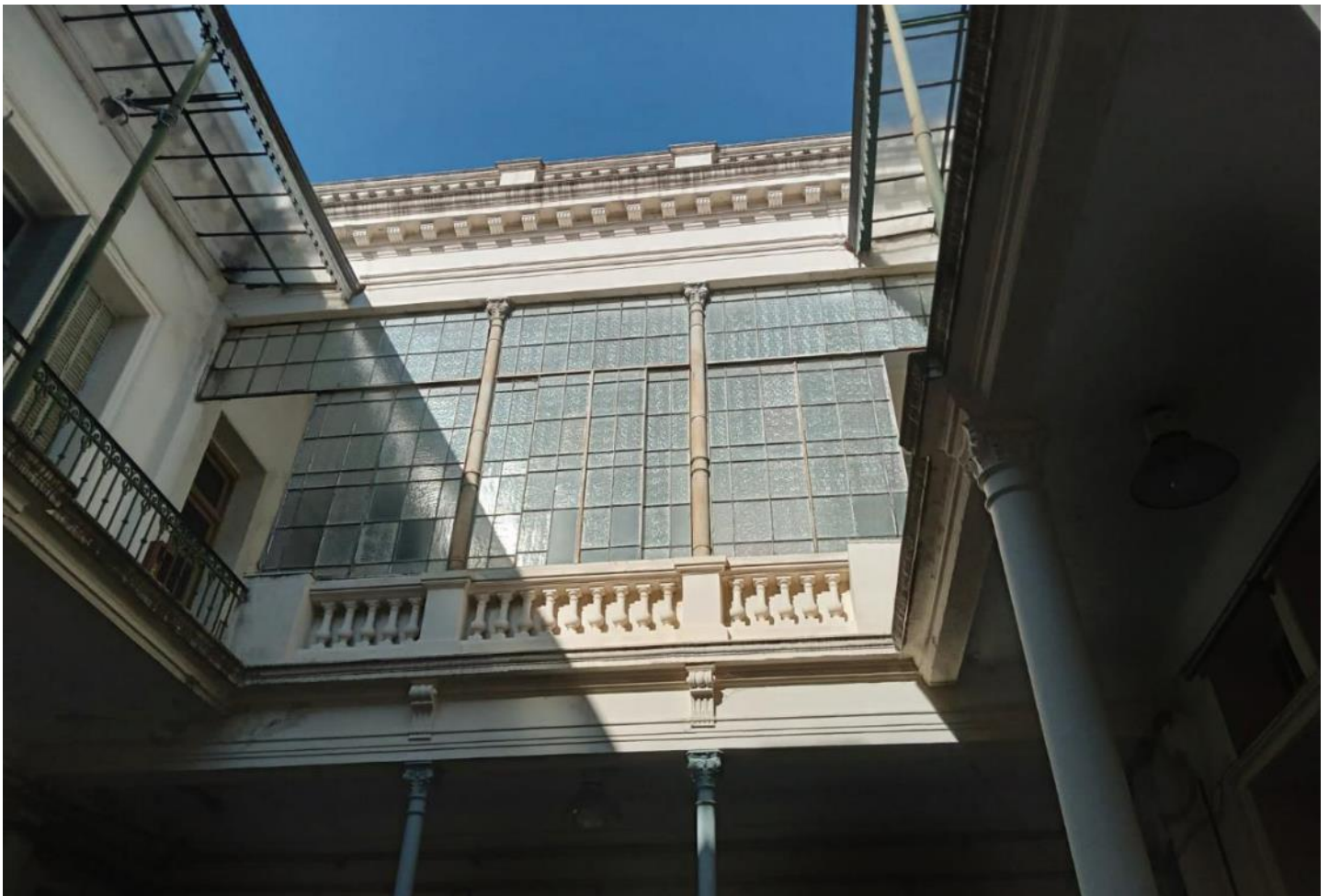
EDIFICIO DECANATO FACULTAD DE CIENCIAS EXACTAS - (ex INTERNADO # 2 DEL COLEGIO NACIONAL "RAFAEL HERNÁNDEZ") ESTADO ACTUAL (PATIO INTERNO)
