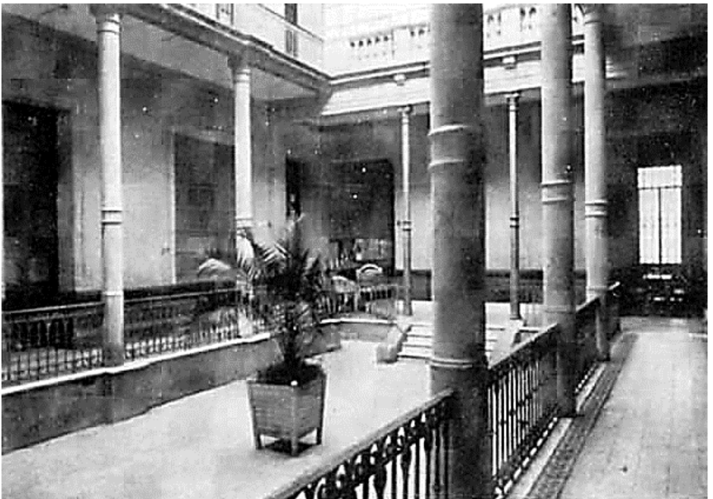
EX INTERNADO 2 (DECANATO DE CIENCIAS EXACTAS) / PATIO INTERIOR.
