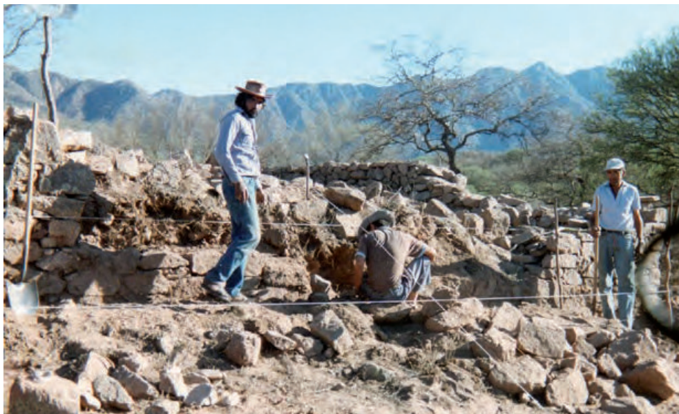
Figura 10. Vista parcial del trabajo de anastilosis vertical realizada en el perímetro del ushnu en el año 1993 (Fotografía de D. Iturriza).
