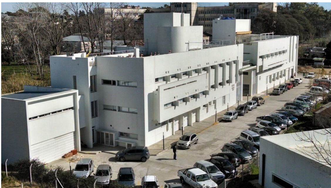
Edificio actual del ILPLA
