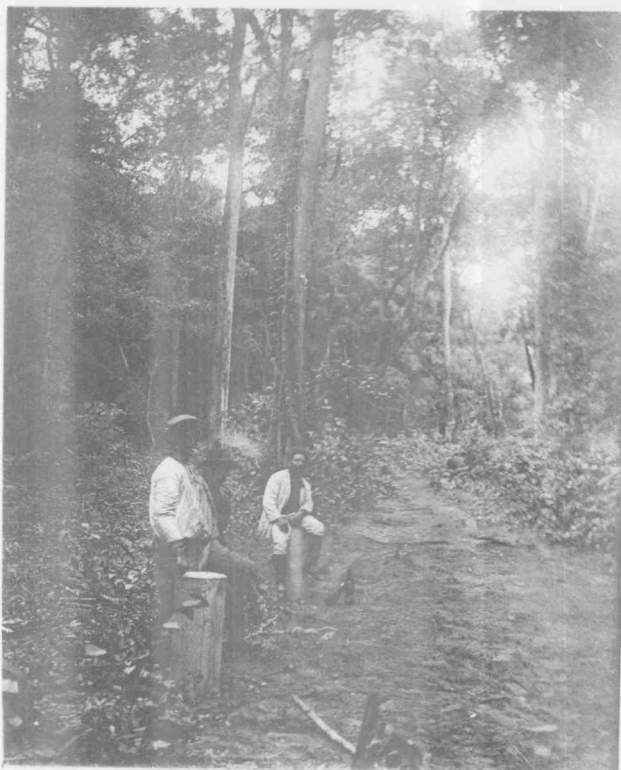
Fig. 16. Camino carretero entre Embarcación y Yacuiba
